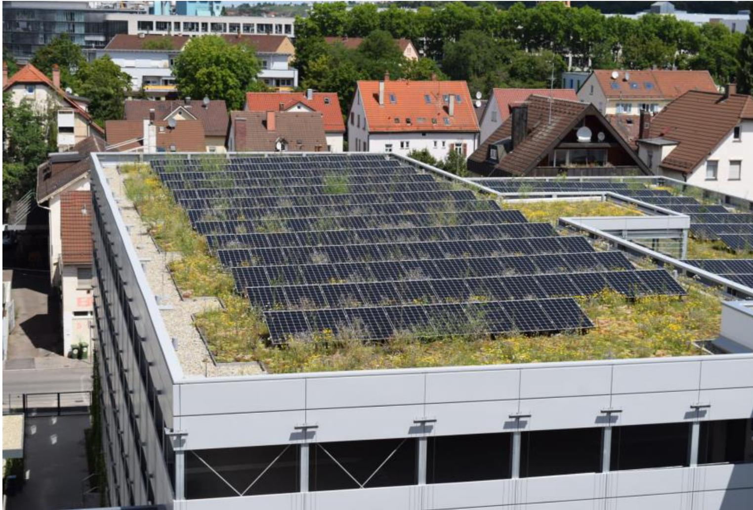
Falsch (zu hoher Substrataufbau und unpassende Saatgutmischung) ...
