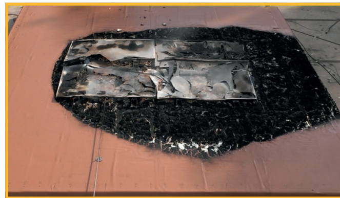
Bild 3 | PU-Dach mit PV-System nach dem Brandversuch
