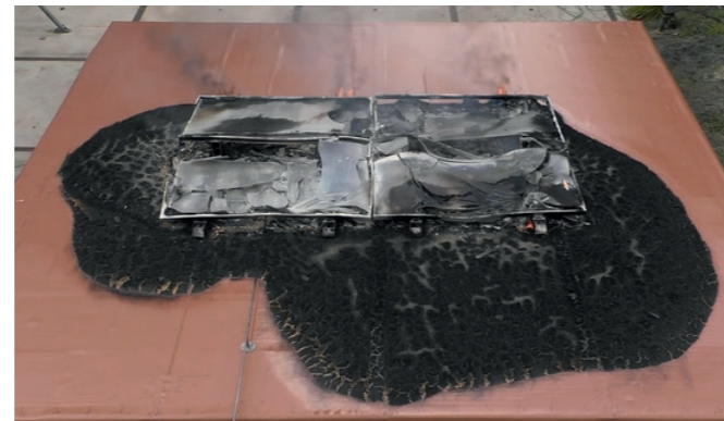
Bild 4 | MW-Dach mit PV-System nach dem Brandversuch
