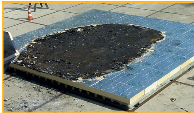
Bild 7 | PU-Dach nach Entfernen der Abdichtungsbahn
