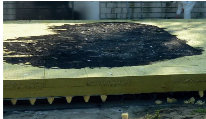
Bild 8 | MW-Dach nach Entfernen der Abdichtungsbahn
